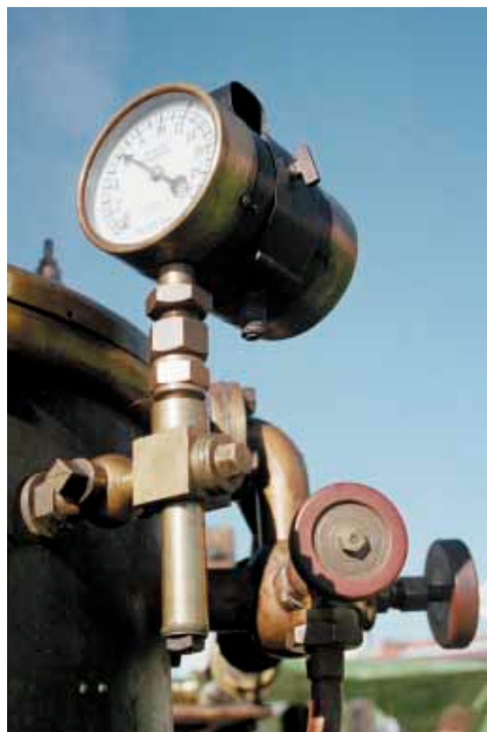
Manometr tlaku páry v kotli.
